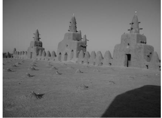
Fig. 8 Mali, Mesquita de Djenné. Vista da cobertura em terraço.
