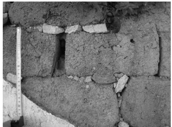
Fig. 9 Martingança (Leiria), adobe wall detail.
